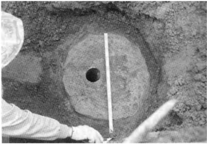
照片1.CCP樁高壓噴射強制攪拌成型樁
